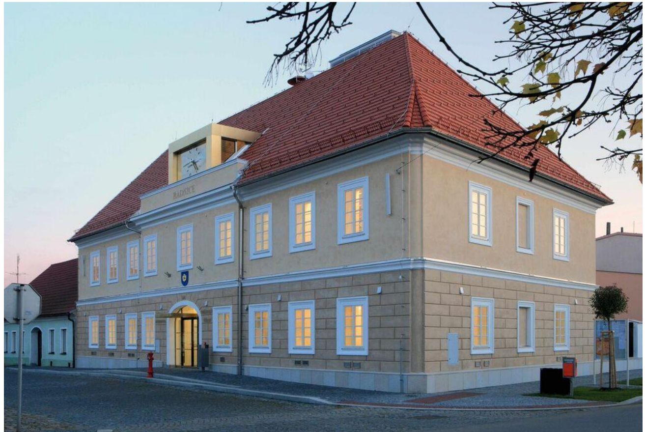
Rekonstrukce radnice a doplnění o knihovnu, Kardašova Řečice Jakub Žiška, Pavel Šmelhaus soutěž: 2013, realizace: 2016
