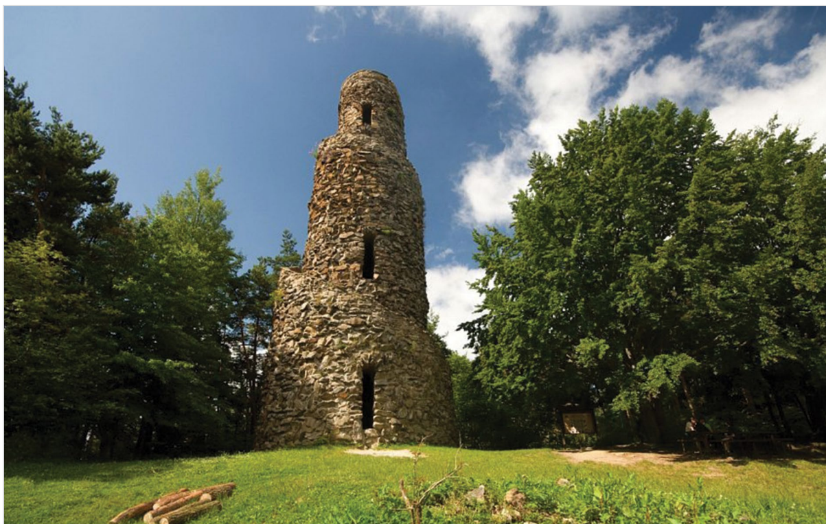
Bukovina, foto: Roman Svoboda
