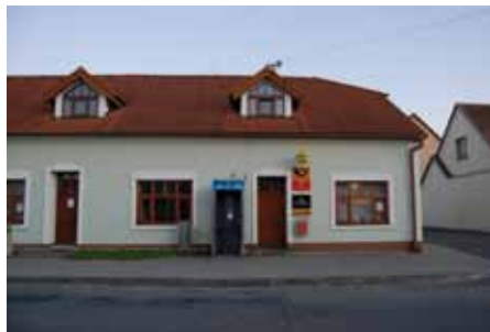
Zruší i tuhle venkovskou poštu?
