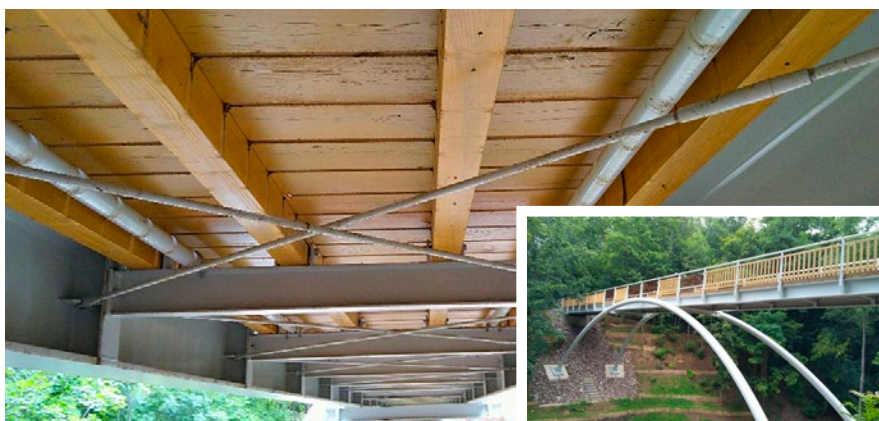
Kontrola dřevěné lávky pro pěší přes rokli
