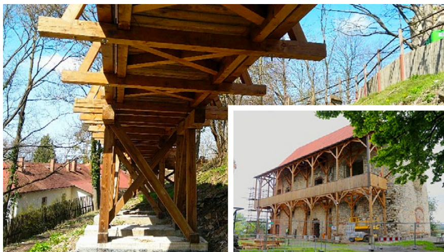
Kontrola dřevěných konstrukcí hradu
