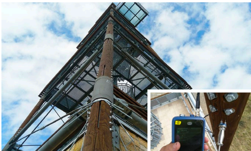
Kontrola rozhledny s dřevěnými prvky
