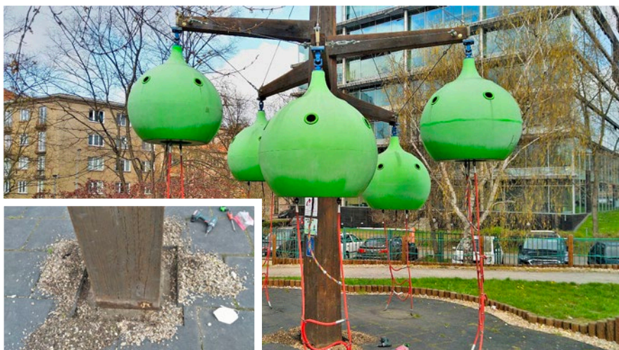
Kontrola dřevěné konstrukce herního prvku
