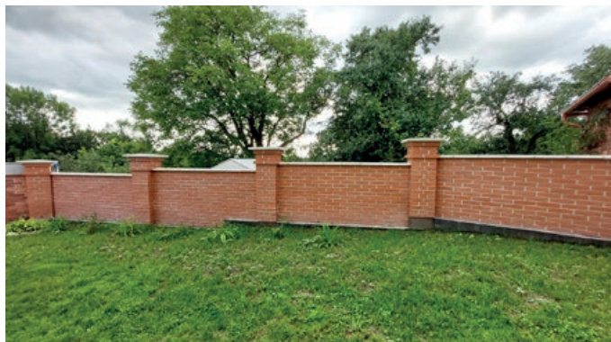
Oprava hřbitovní zdi v obci Černčice
