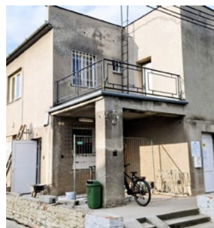
Před a po rekonstrukci
