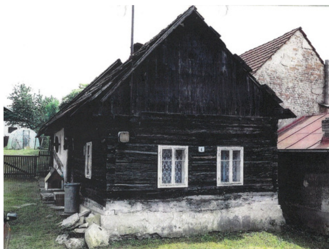
Před obnovou (@Luděk Ovesný)
